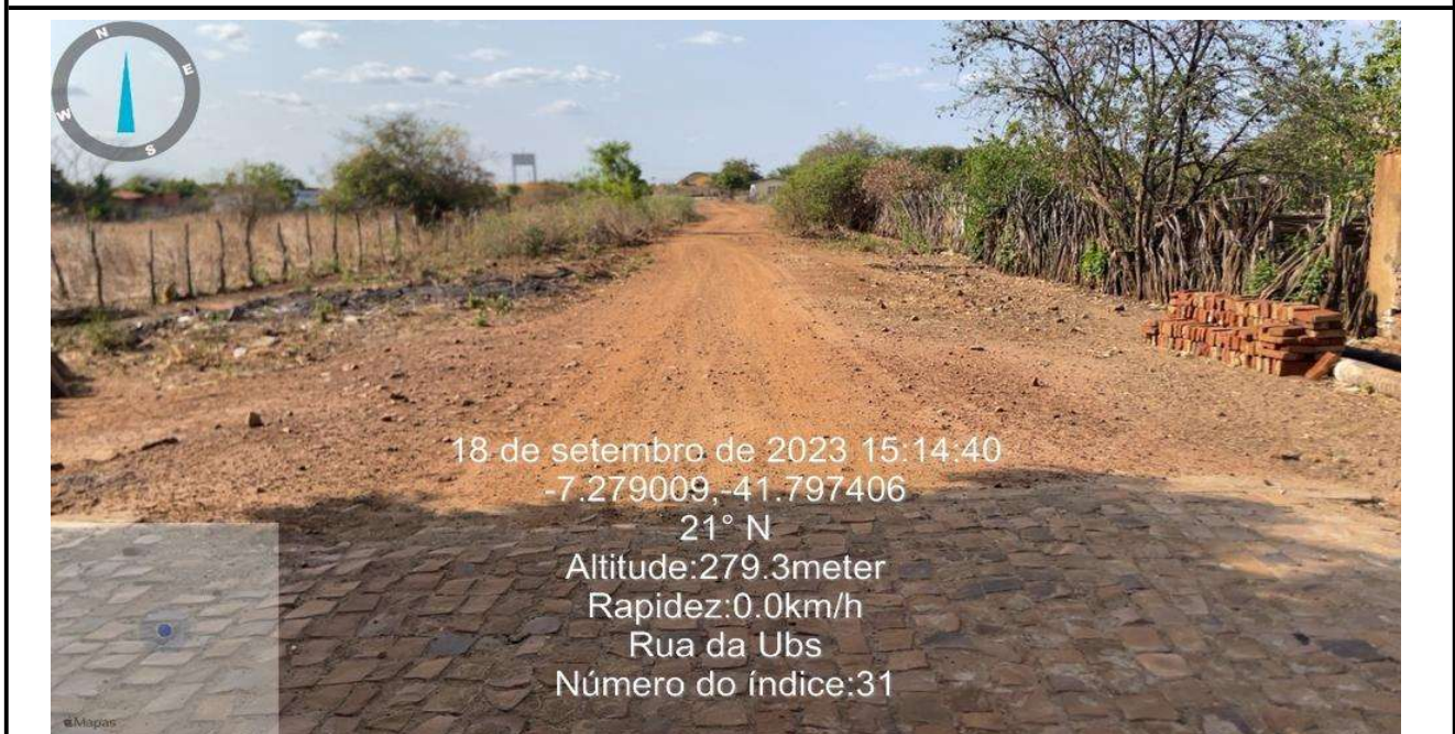
Foto Nº 02 - RUA DA UBS
