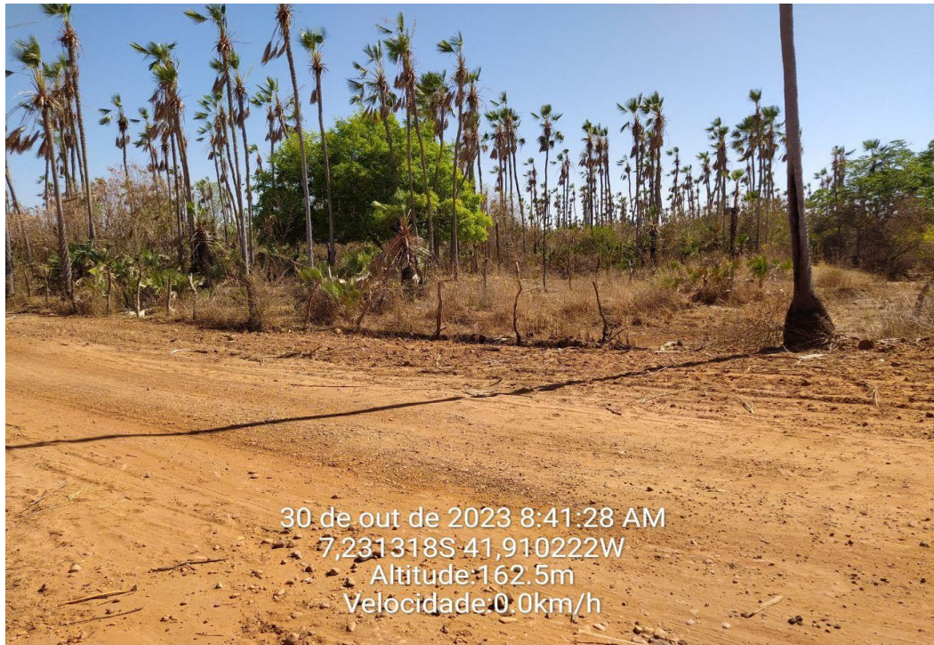
FOTO 09 - PASSAGEM MOLHADA 01 - TRECHO 01
