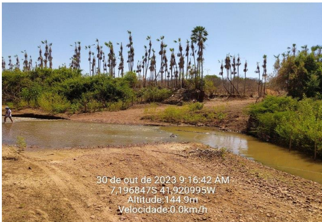
FOTO 10 - PASSAGEM MOLHADA 02 - TRECHO 01
